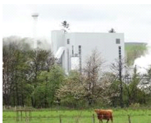
Die Anlage der Rothes CoRDe Ltd ist ein biomassebefeuetes Blockheizkraftwerk in Schottland. Als Brennstoff werden
