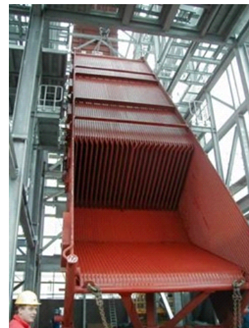
Montage des Überhitzerteils eines Kessels
