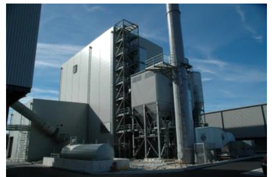
Das Biomasse-Kraftwerk Western Wood Energy hat heute noch einen elektrischen Netto-Wirkungsgrad von 30%, obwohl die Anlage im Jahr 2005 gebaut wurde.
