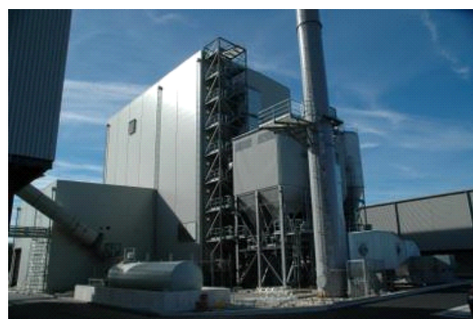
Das Biomasse-Kraftwerk Western Wood Energy hat heute noch einen elektrischen Netto-Wirkungsgrad von 30%, obwohl die Anlage im Jahr 2005 gebaut wurde.
