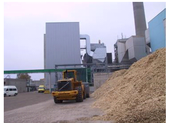
Das BHKW Linz-Mitte hat einen sehr hohen Gesamtwirkungsgrad von 85-87%.
